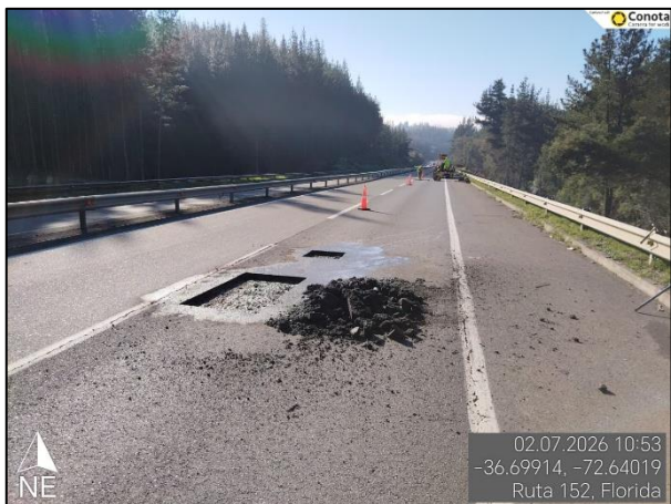
Imagen N°2. Trabajos de bacheo. Ruta 152 Florida, Km 38.400
