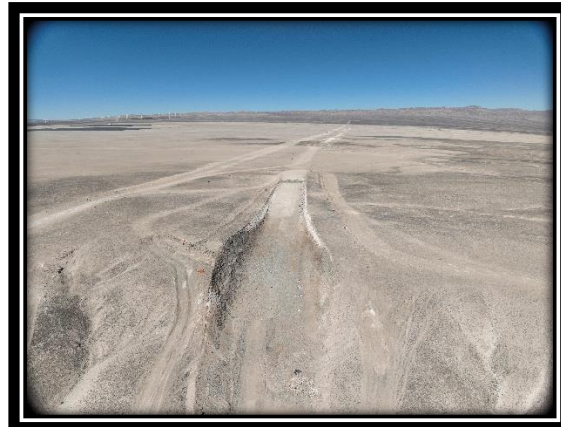
Obras Realizadas antes de la Paralización
