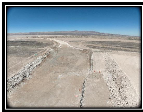
Obras Realizadas Antes de la Paralización
