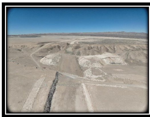
Obras hasta antes de Paralización Sector B
