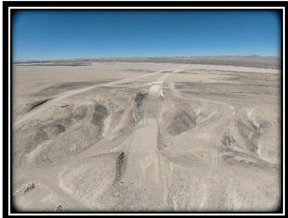
Obras Realizadas antes de la Paralización
