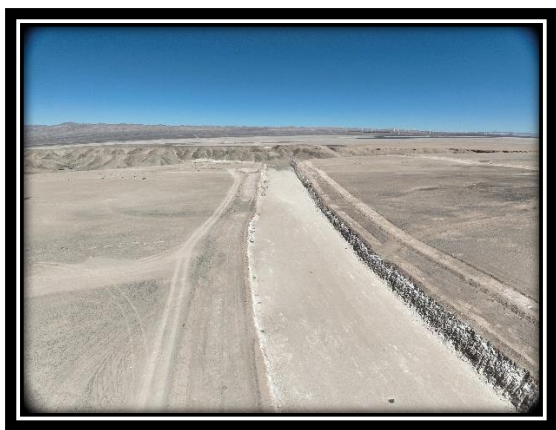
Obras Realizadas antes de la Paralización
