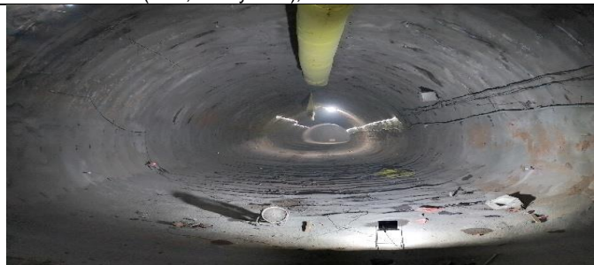
Túnel Vía Expresa Poniente, frente 2, continúa avance en confección de contrabóveda, fases 5, 6 y 7 de sur a norte.
