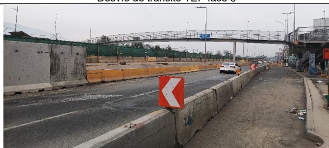
Desvío de tránsito Túnel Expreso Poniente fase 3, sector Av. El Valle.
