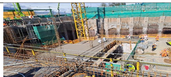
Edificio de Control: Hormigonado de losa cielo del segundo subterráneo, entre los ejes 5 – 8 y A – B.
