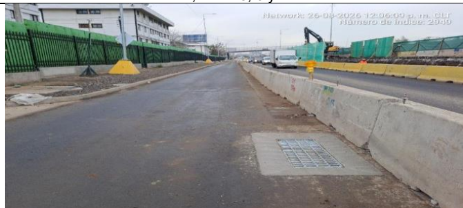
Desvío de tránsito TEP fase 3
