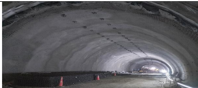
Túnel Vía Expresa Poniente, frente 1, avance en proyección de revestimiento (HP1, HP2 y HP3), en tramo Dm 8.547 a Dm 8.800.
