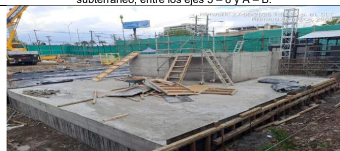
Sala Eléctrica Tobalaba: Muros del sector escotilla de entrada y salida de la Sala Eléctrica ya hormigonados y desencofrados
